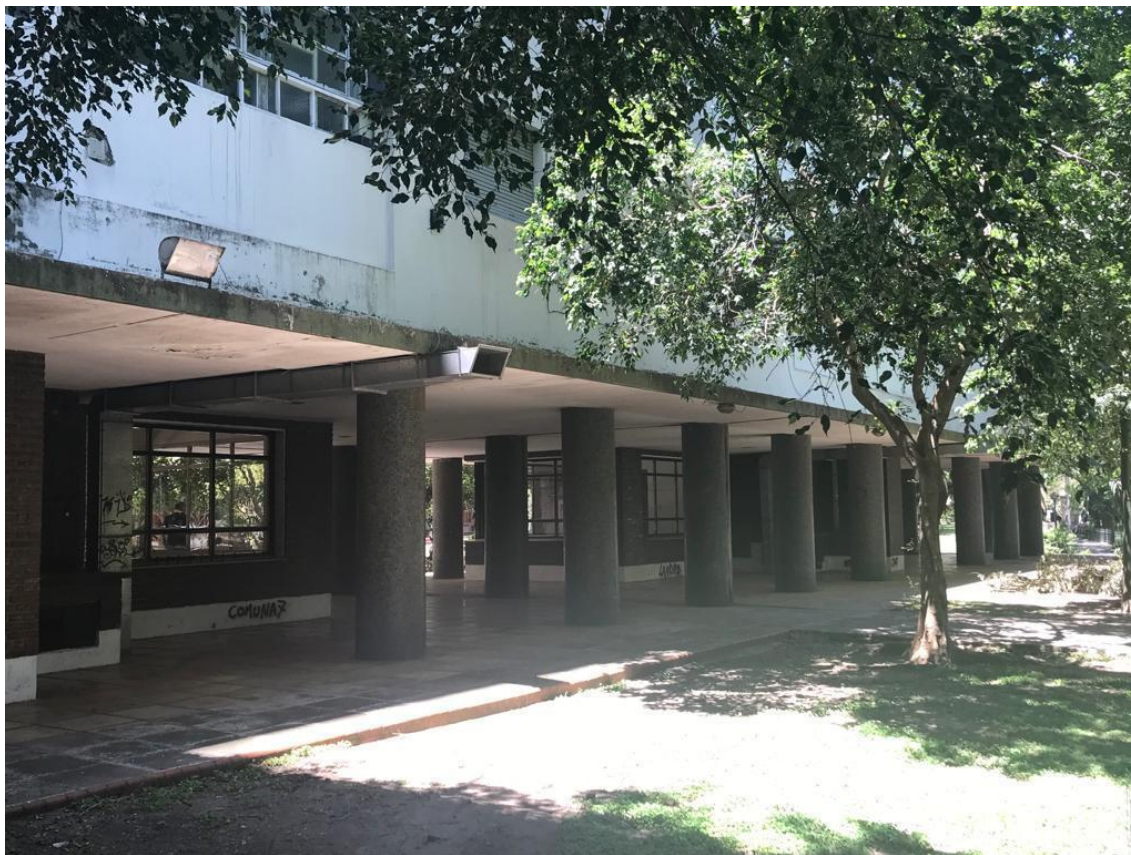
Figura 2: Planta baja libre en el Conjunto Simón Bolívar
