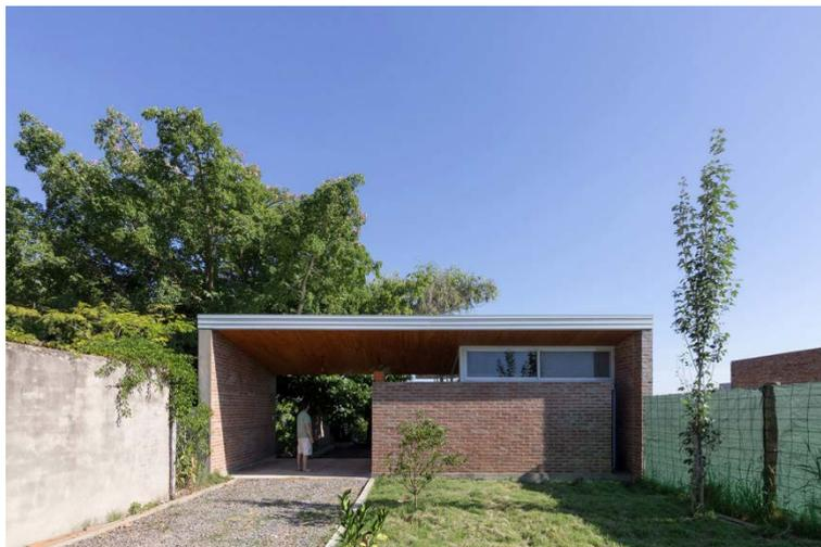
La casa es definida por los dos planos horizontales del suelo y de la cubierta, que se despega de las paredes para optimizar el ingreso de aire, luz y verde.
