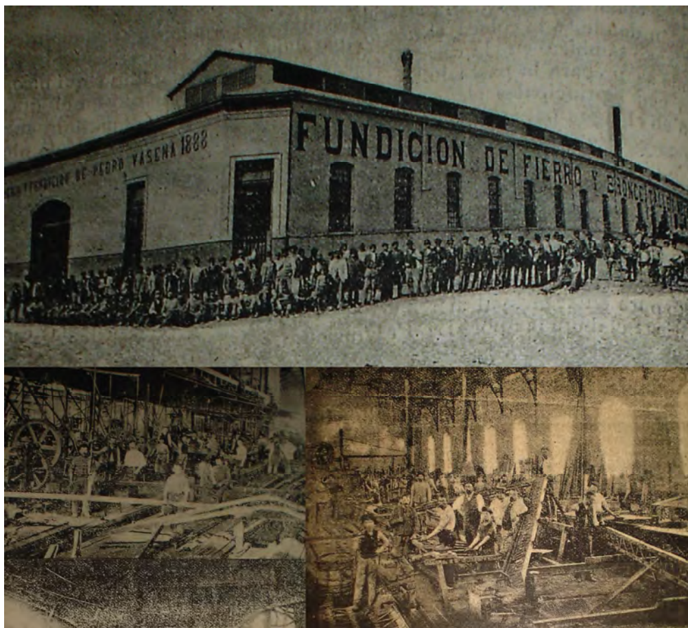
Talleres metalúrgicos Vasena. UIA (1895,p.80 a 87)
