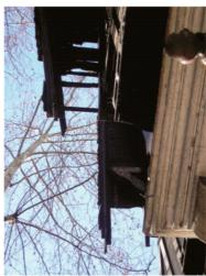
Sectores faltantes de cubierta y aleros - tejas cerámicas, aislante, canaletas, tablado y estructura de madera - sectores del interior expuestos la acción directa de agentes atmosféricos y al ingreso de aves. Grave deterioro en toda la cubierta.
