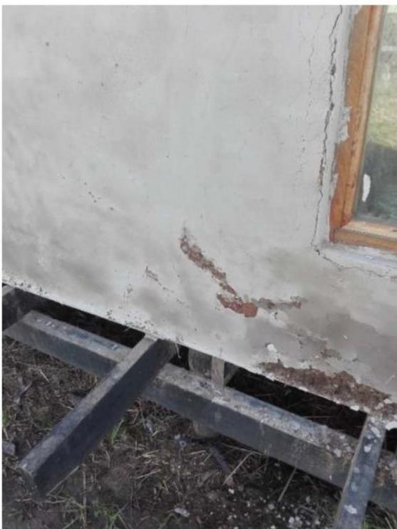
Muro en fachada SO: fisuraciones y desprendimientos. Bulines de madera para instalación de agua.
