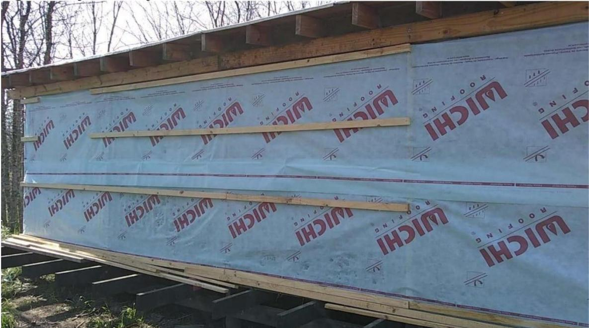
Muro en fachada SO, subcobertura hidrófuga y controladora del vapor de agua y bulines de madera para instalación de cañas.
