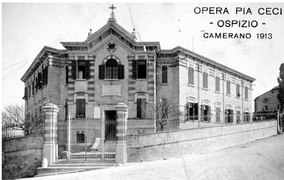
Figura 8. Fondazione Ceci. Via Marinelli y Strada Provinciale Cameranesa, Camerano, Ancona, Italia.
