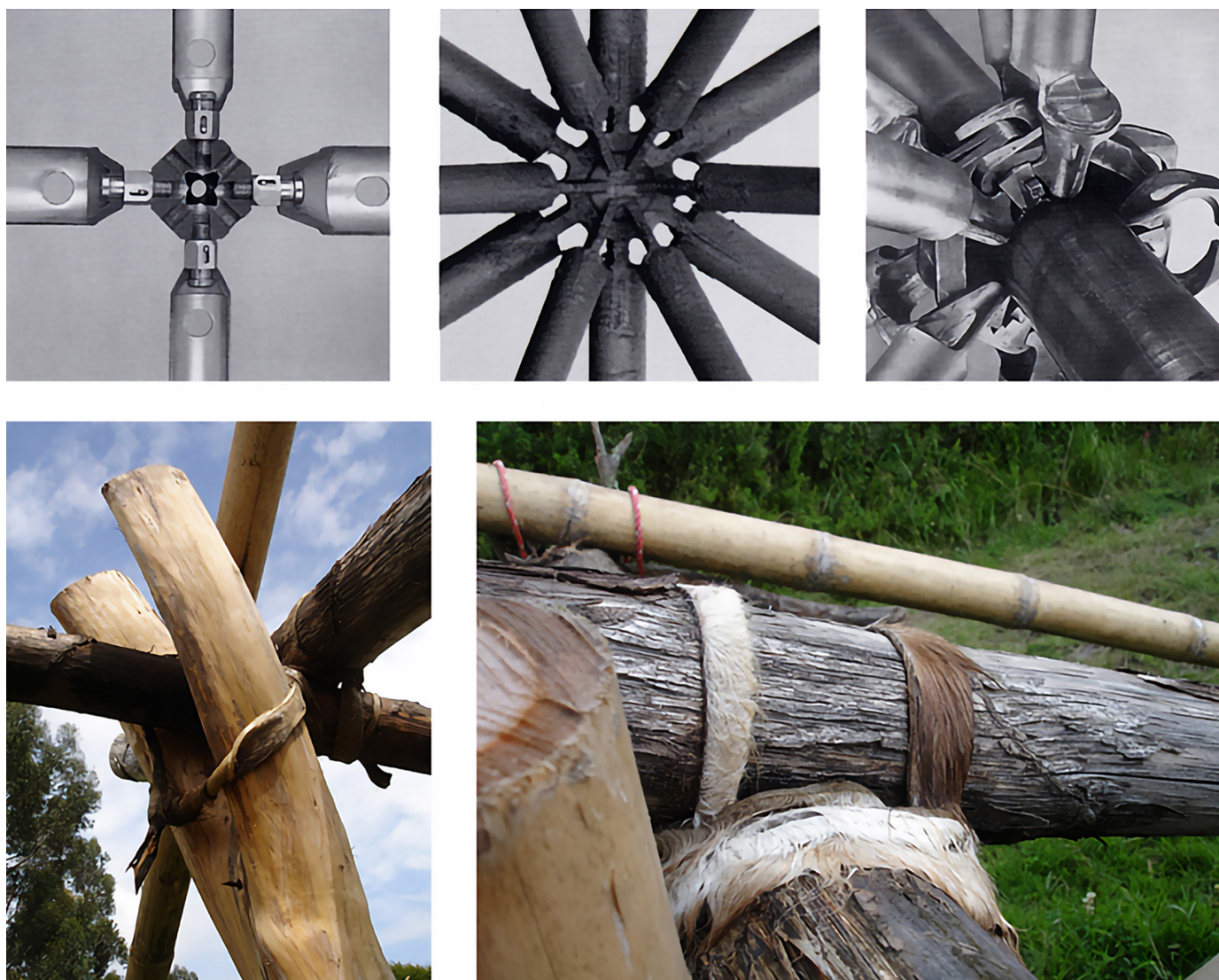
Figura 1 Colección de resoluciones constructivas para encuentro entre caños o palos. Arriba: accesorios metálicos. Abajo: ataduras con cuero animal. Fuente: gentileza de Al Borde.
