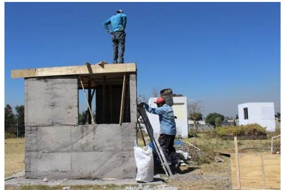
**Figura 6.** Nuevo prototipo de tierra vertida con muros de 14 cm de espesor. (Foto: Luis E. Martínez Barrón)
