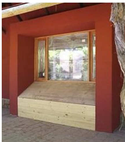
Figura 4. Ventana abierta a corredor y jardín poniente conectando sala de catas
