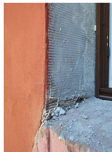
Figura 6. Aplicación malla de fibra de vidrio con Propasta E.
