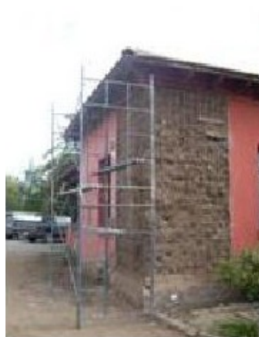
Figura 5. Vista de reforzamiento esquina sur-oriente mediante malla metálica electro-soldada.
