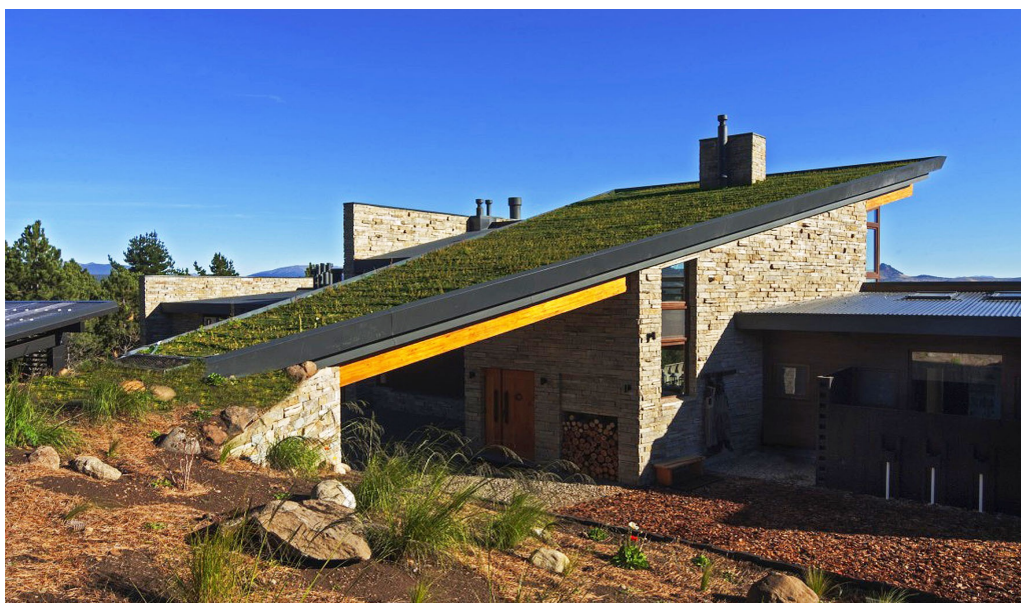
Figura 2. Terraza Verde con pendiente mayor a 15°, no transitable, vegetación sedum y nativas, de bajo mantenimiento. Urbanización El Desafío, San Martín de los Andes, 2014.
