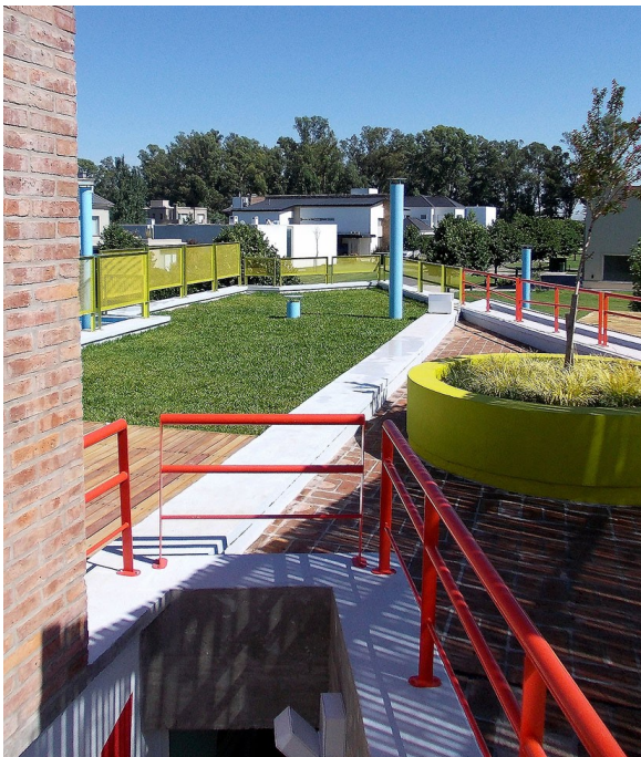
Figura 5. Terrazas Verdes transitables con espesor de 20cm, mantenimiento periódico, riego automatizado, en CASAORDENADA de Clorindo Testa, Kentucky, Funes, 2012.
