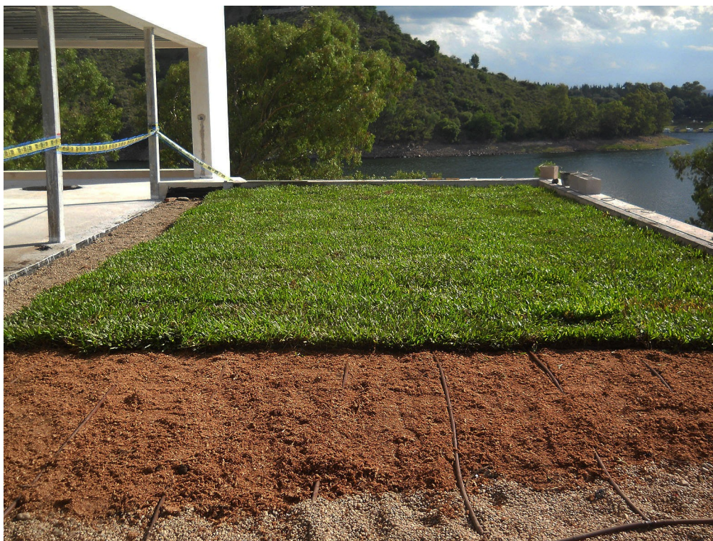
Figura 3. Proceso de construcción en cubierta plana. Uso: expansión de dormitorio. Terraza Verde transitable, césped, riego automatizado por goteo, mantenimiento periódico, en Dique los Molinos, Villa Ciudad de América, Córdoba, 2014.
