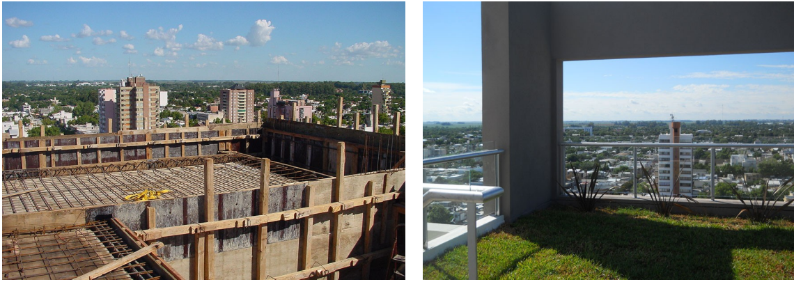
Figura 7. Antes y después, construcción de losa de hormigón con terminación en cubierta vegetal. Usos: solárium y expansión del SUM. Terrazas Verdes en piso 17 y en planta baja sobre cocheras del edificio, Venado Tuerto. 2010.
