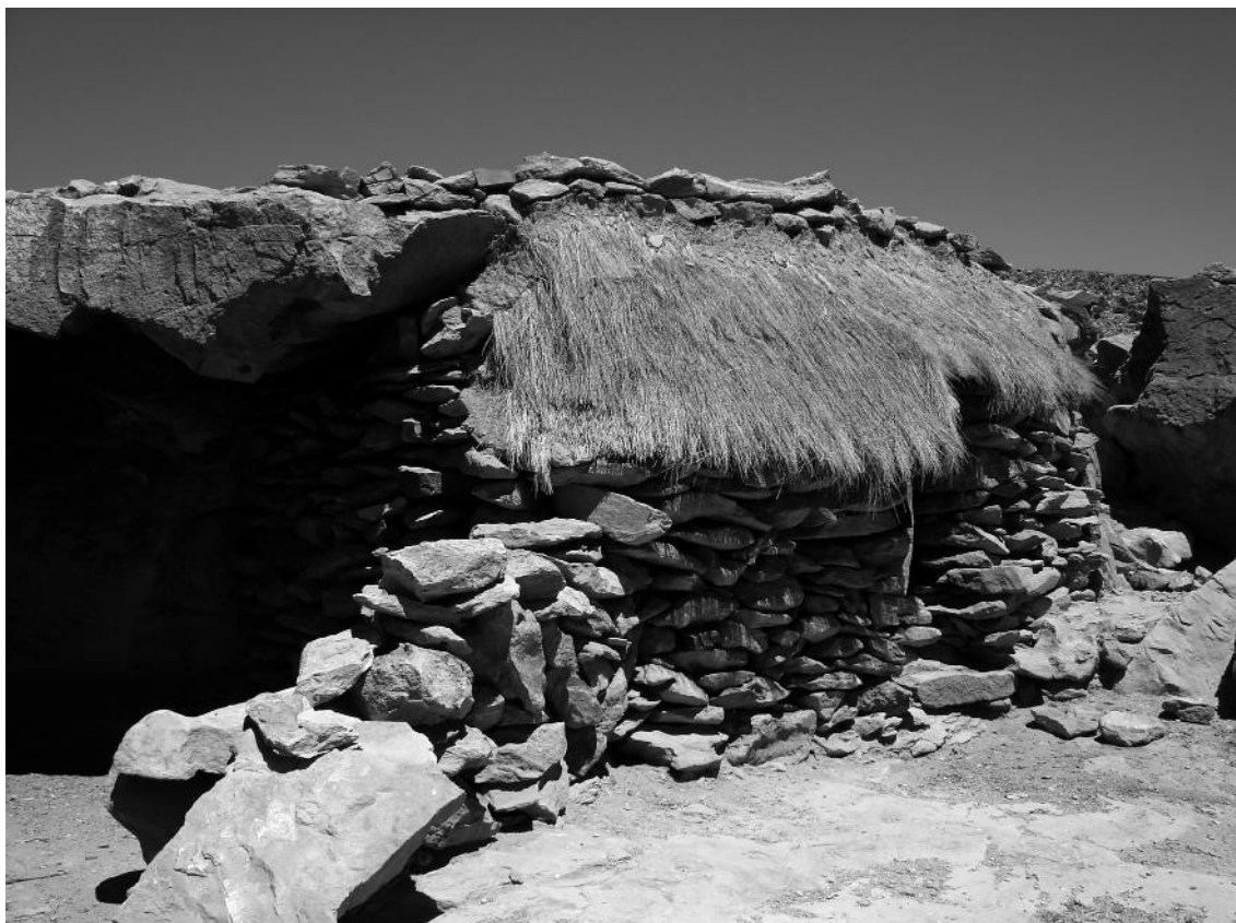
Figura 4. Puesto de pastoreo en Susques, construido en pirca seca, aprovechando un alero rocoso (Fotografía: J. Tomasi)
