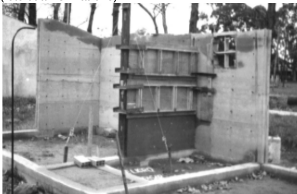
Encofrados fenólicos. (foto Juan C. Patrone)
