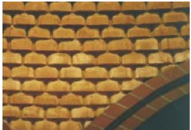
Vista interior de las cúpulas de adobes redondeados
