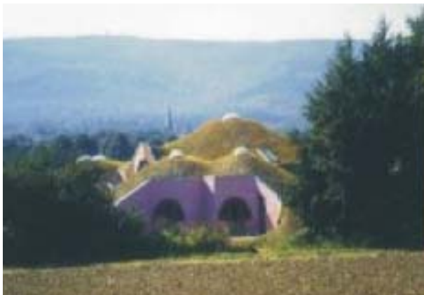
Vista exterior de los techos verdes.
