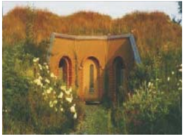
Vista exterior de los techos verdes.
