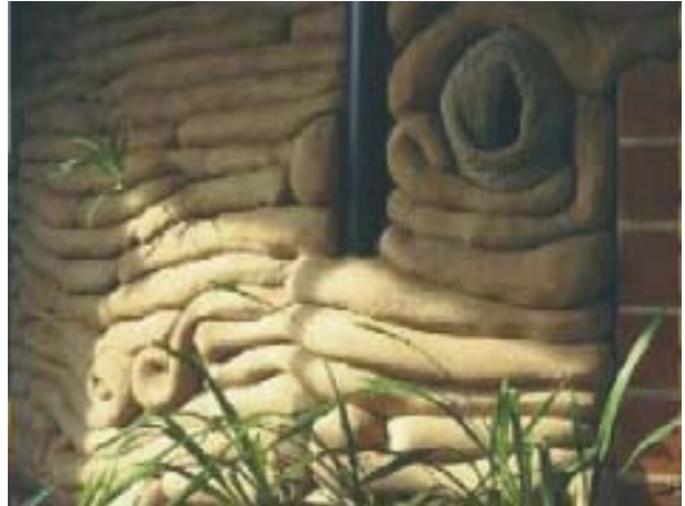
Detalle en muro de baño.
