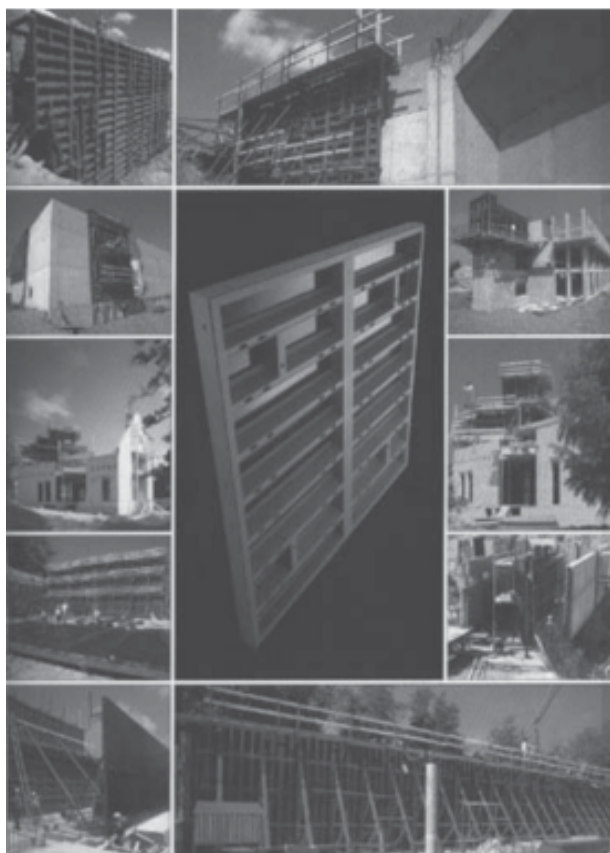
B.- Tecnologías del H°A°: encofrados deslizantes, los mis-mos también podrían ser utilizados para tapias de adobe.
