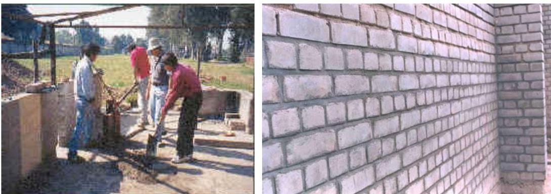
Figura 3: fabricación de BTC y muro exterior del sector Laboratorios con terminación vista
