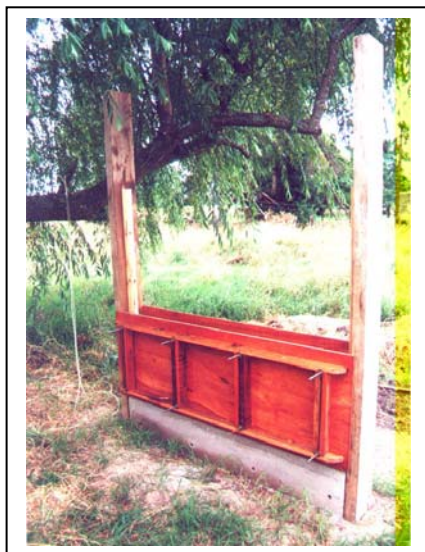
Experiencia de campo – Encofrados Fotos M. Cabezón
