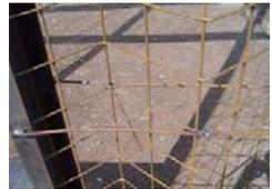
El adobe preparado con suficiente fibra se adhiere a la estructura de acero, el barro es aplicado por medio de la técnica del estuco, adaptándose como masa amorfa a las características que impone la estructura.
