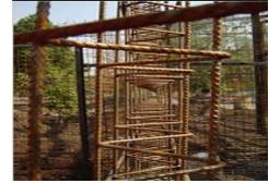
La malla plegada es fijada, y reforzada por una estructura de perfiles de acero, vigas y pilares debidamente asentados a los cimientos unen esqueleto y malla entregando la estructura del muro. Funcionan como nervaduras
