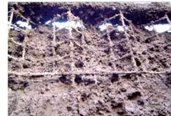
El adobe es aplicado en dos formas manual y con maquina de presión comúnmente utilizada en la aplicación del hormigón en la construcción de muros de piscinas. Por el lado contrario a la aplicación del adobe una plancha de OSB hace las veces de moldaje unilateral, el cual recibe la fuerte aplicación del barro a presión.
