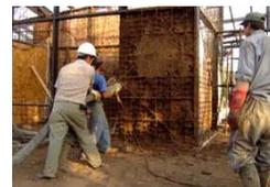
Una vez aplicada la masa se procede a nivelar el adobe, los fierros de apoyo entregan una visión de secciones verticales y horizontales que forman una cuadrícula. Con esto el muro esta construido y listo para darle el revestimiento exterior que puede ser el estuco con el mismo barro o con otro material.
