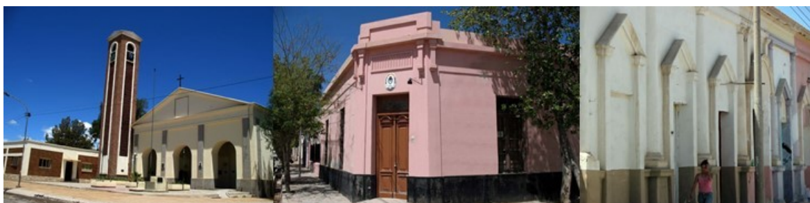
Figura 7: Típicas construcciones con tierra de San José de Jáchal: Iglesia, Comisaría y detalles de fachadas de adobe. Fotos: R. Ruiz (2007)
