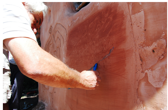
Figura 8. Estucado sobre terminaciones
