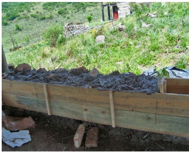
Figura 3. Muro de barro encofrado con piedra incorporada del lado externo.
