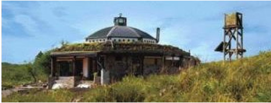
Figura 5. La construcción previa de los techos es una técnica que facilita la construcción con tierra cruda al proteger los muros de los agentes climáticos desde el inicio de la obra.
