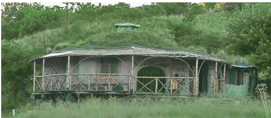
Figura 1. Vivienda típica en la Eco-aldea Salsipuedes, utilizando ‘barro encofrado’ con exterior de piedra en las zonas inferiores y muros expuestos a la intemperie, y revoque liso en las galerías e interiores.
