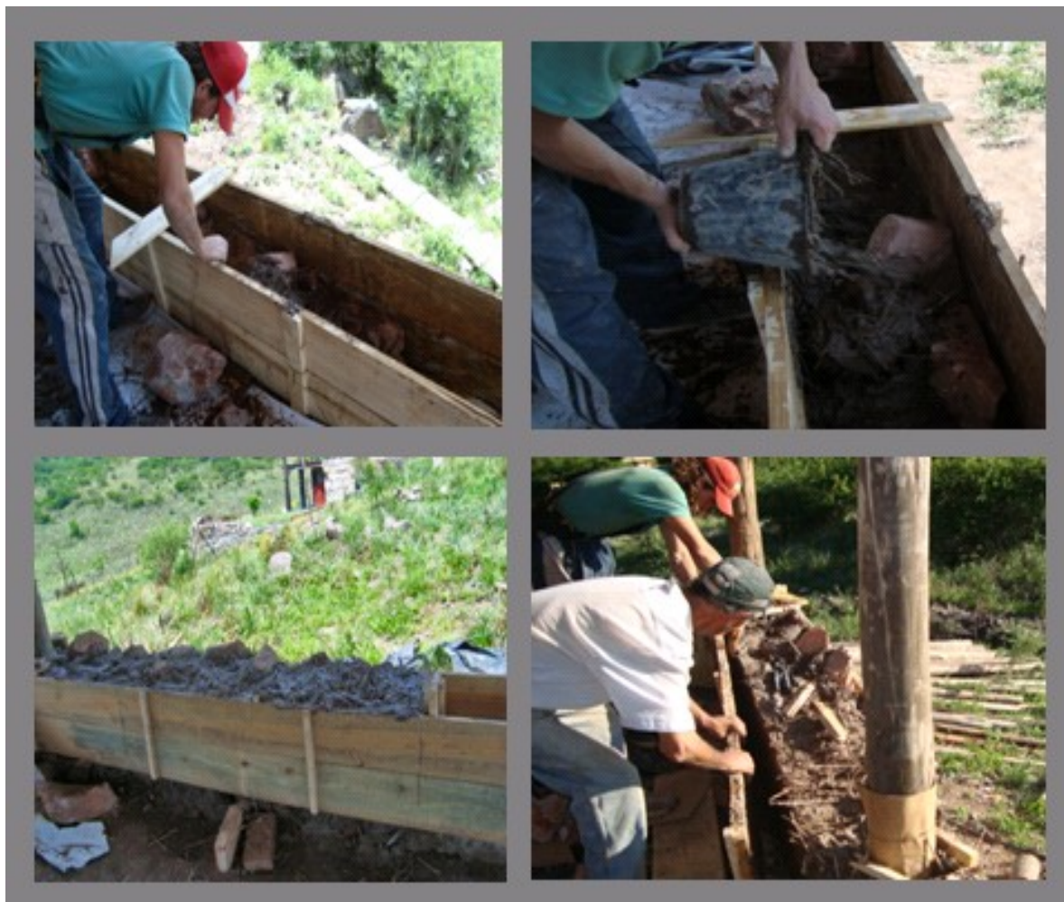
Figura 4. Barro encofrado, proceso constructivo.
