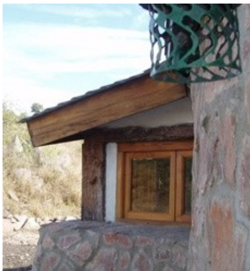
Figura 2. Muro de adobe, sin alero, protegido por doble muro de piedra.
