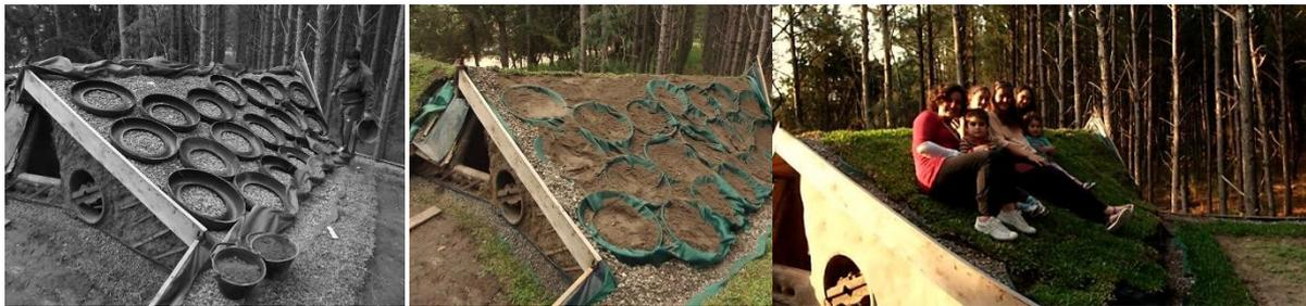
*Figura 6. Proceso de construcción Techo vivo inclinado*
