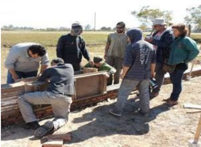
Figura 11. Ejecución de muro de Tapia.
