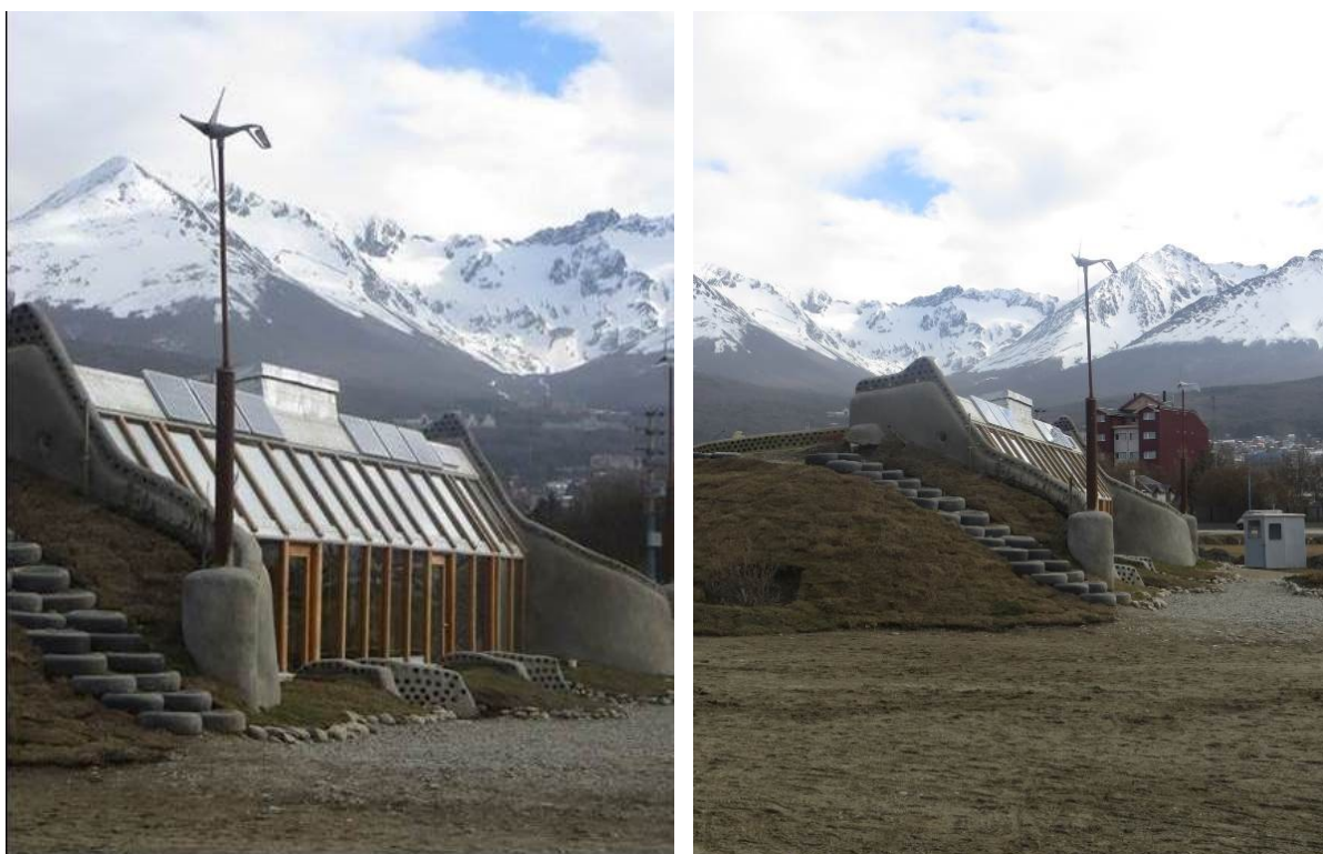
Figura 6. Sistemas de energía renovable en el Earthship de Ushuaia: invernadero, módulos fotovoltaicos y aerogenerador. Fotos: J. M. Evans.
