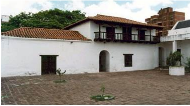
Figura 4. Casa de los Aldao, construcción del 1600 en tapia (recientemente restaurada 5 ). Banco de Imágenes Florian Paucke.
