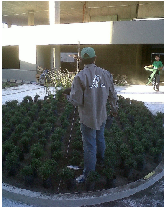
Figura 6. Terrazas Verdes no transitables con espesor de 6cm, bajo mantenimiento, en Oficinas Bureau Parc San Isidro, Buenos Aires, 2013-2014.
