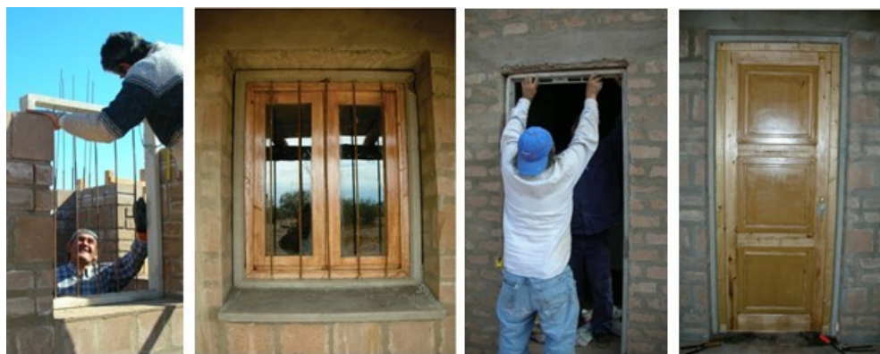
Figura 10. Pruebas de autoconstrucción para el montaje de los marcos de hormigón armado de ventanas y puertas (Blasco Lucas y Carestia, 2011, Blasco Lucas, 2013).
