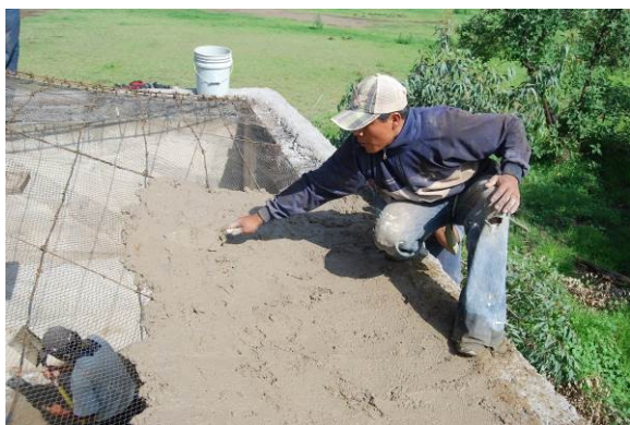
Figura 3. La primera capa de tierra vertida sobre la malla metálica. (Foto: L. Guerrero)
