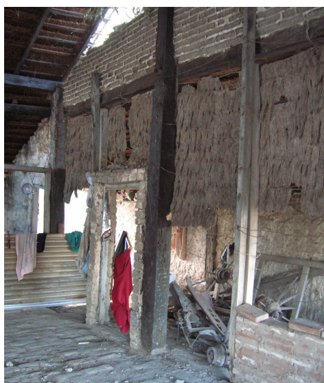
Figura 11. Pared realizada de paja embarrada en Isla Poí
