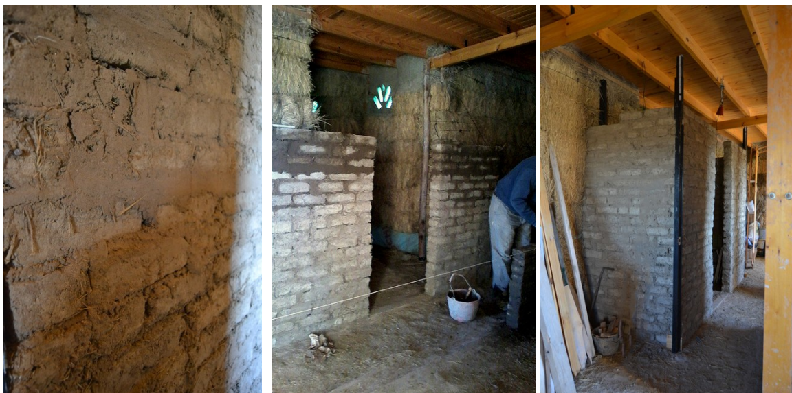
Figura 7. Paredes interiores. Ladrillos de adobe.
