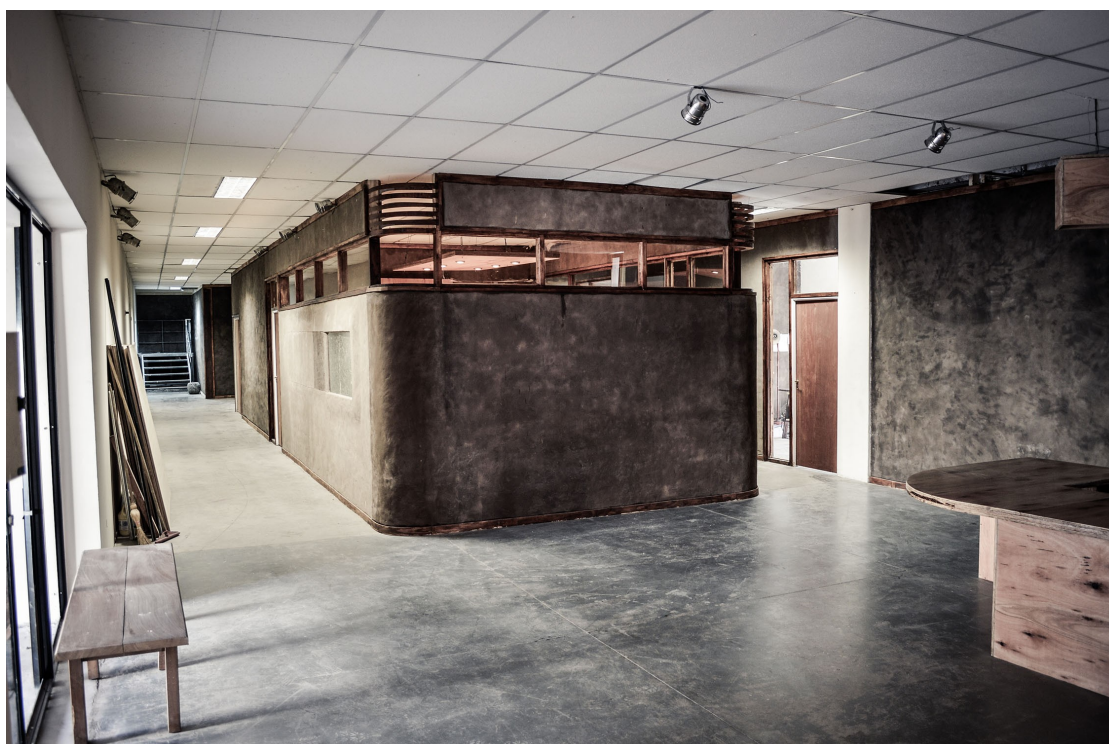
Figura 1a. Muros divisorios interiores con paja encofrada.
