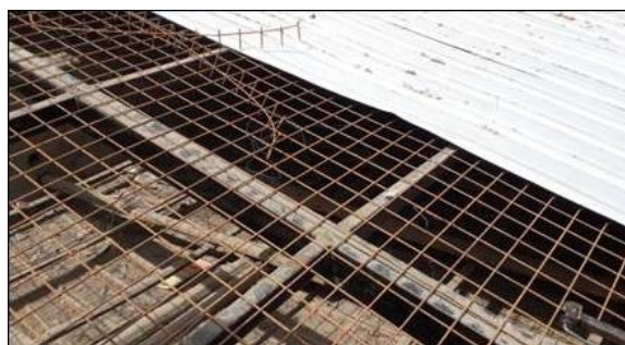
Figura 13: Intervención en cubierta de edificación patrimonial
