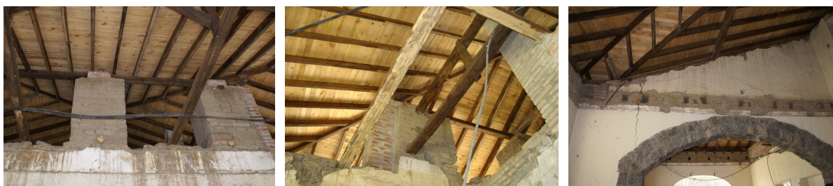
Figura 10: Casa de Hacienda 'San Vicente', intervención realizada en la cubierta.
