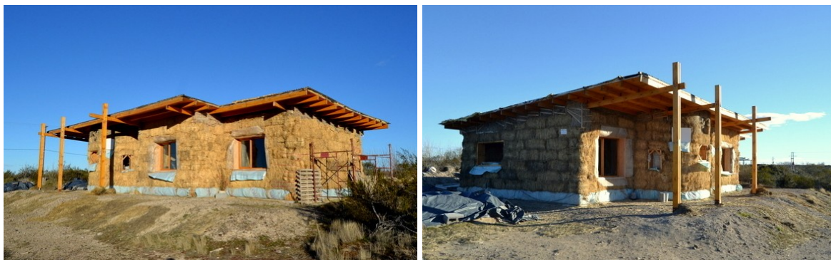
Figura 5. Frente. Fachadas Noreste y Noroeste.
