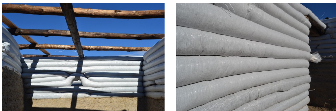
Figura 3. Detalles. Cerramientos y estructura de cubierta.
