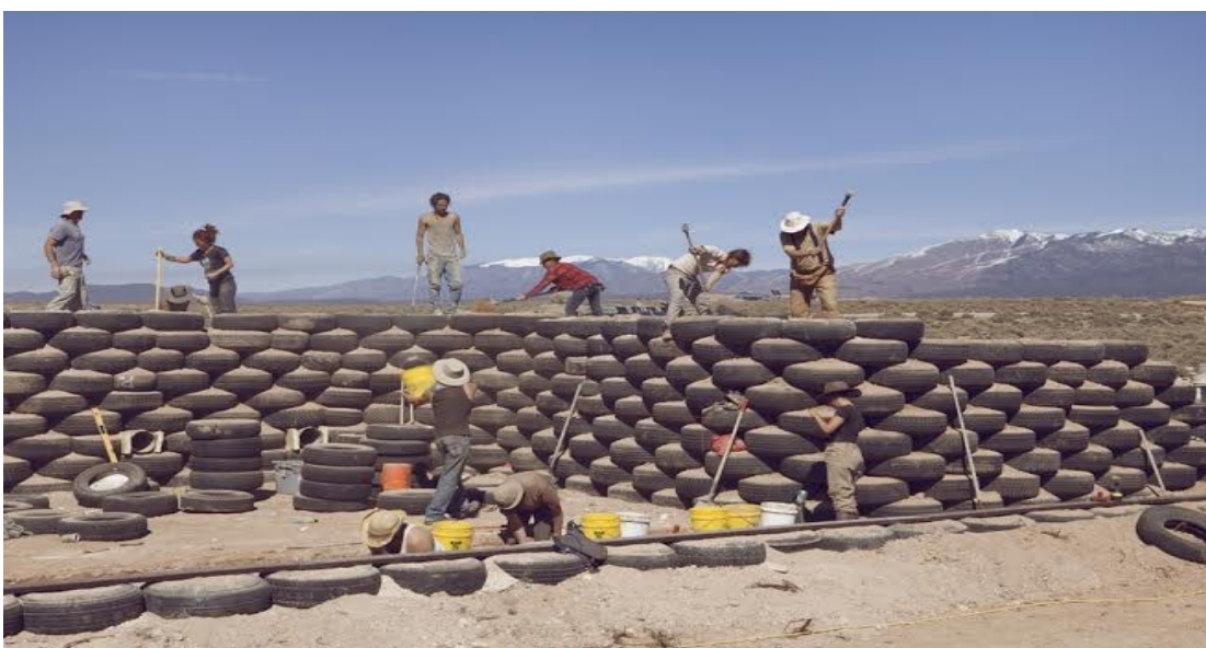
Figura 3. Paredes de neumáticos llenos de tierra, característica emblemática de los Earthships. Imagen: EarthshipBiotecture.
