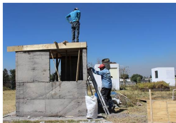
Figura 6. Nuevo prototipo de tierra vertida con muros de 14 cm de espesor. (Foto: Luis E. Martínez Barrón)
