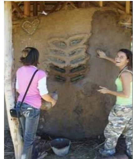
Figura 12. Participantes del taller realizando revoques.
