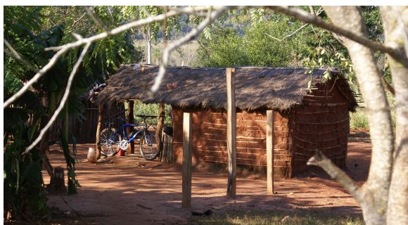
Figura 1. Vivienda Mbya Guaraní con muros del tipo “estaqueo”
