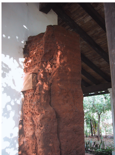
Figura 9. Muros de tapia en San Ignacio Guasú
