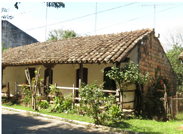
Figura 7. Vivienda en Caapucú donde un área sin protección de aleros, es defendida por una cáscara exterior de ladrillos
