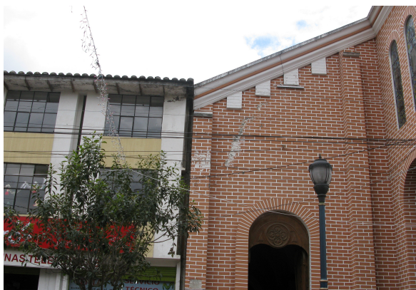
Figura 7: Adosamiento de construcción de hormigón armado a edificación patrimonial
