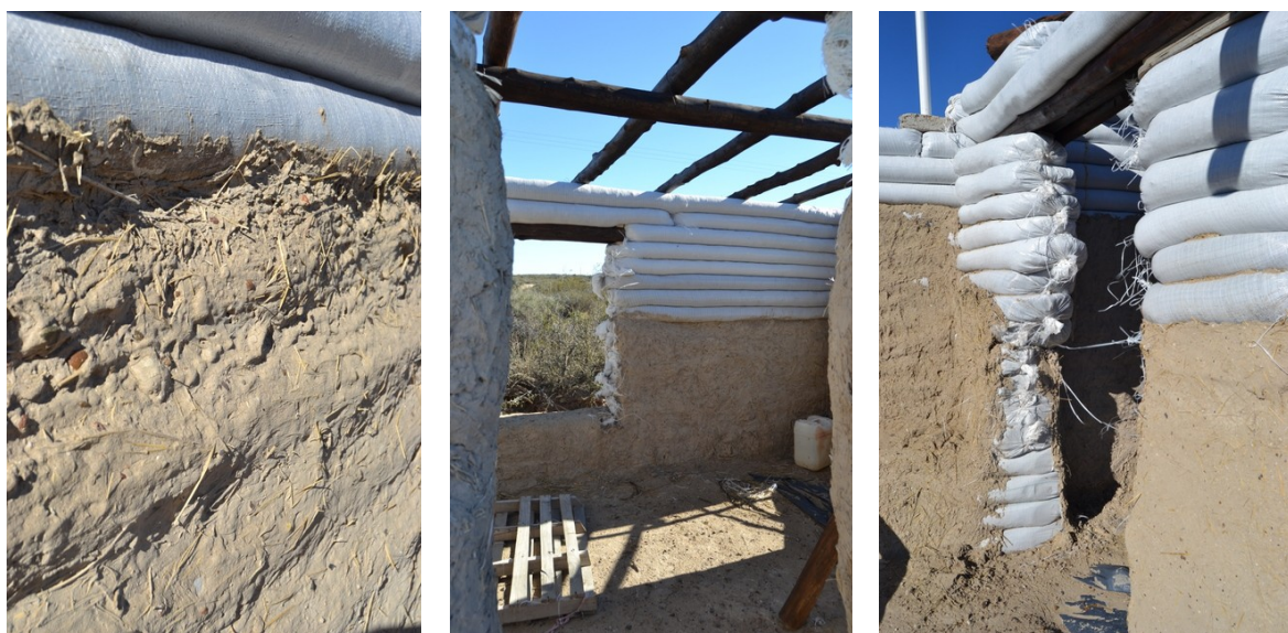
Figura 4. Detalles. Aberturas. Mortero de tierra.
