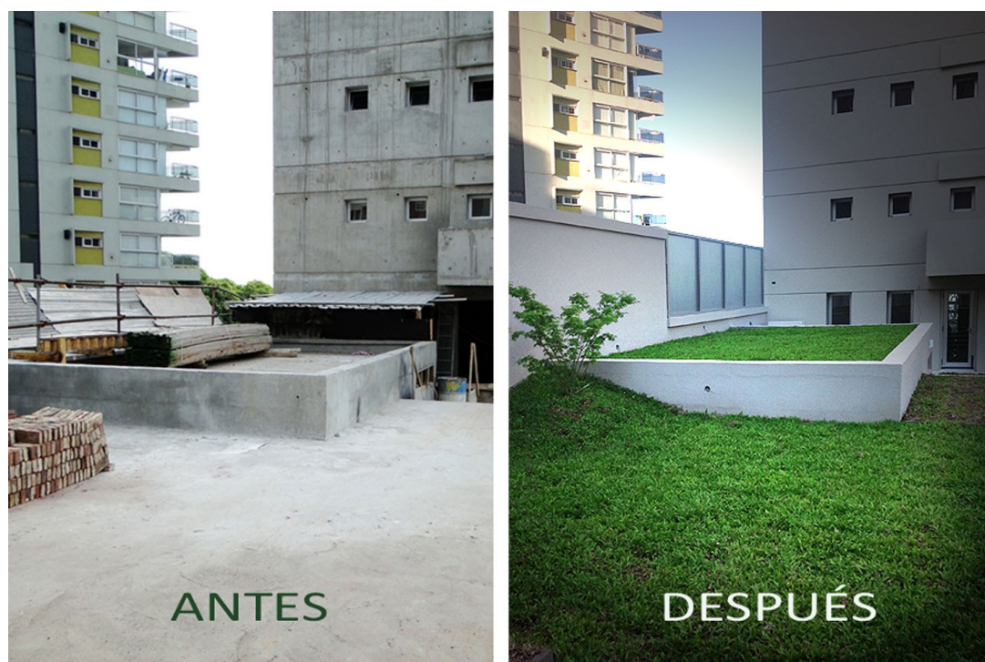
Figura 1. Antes y después en techos planos, 6° piso, uso: solarium y recreación. Losas sobre cocheras del edificio. Terrazas Verdes transitables, césped y plantas individuales, espesor de sustrato de 10 a 80 cm, riego automatizado, Rosario, 2012.
