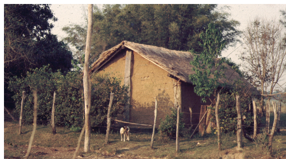
Figura 2. Vivienda rural en la zona del Guairá, se observa la estructura de soporte del techo.
