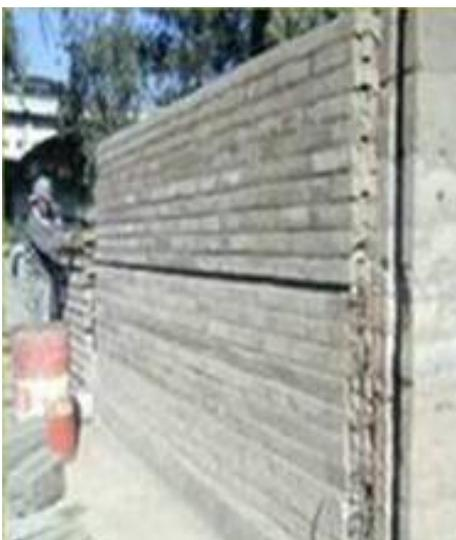
fig. 2 Bloque articulado de suelo-cementocomprimido
