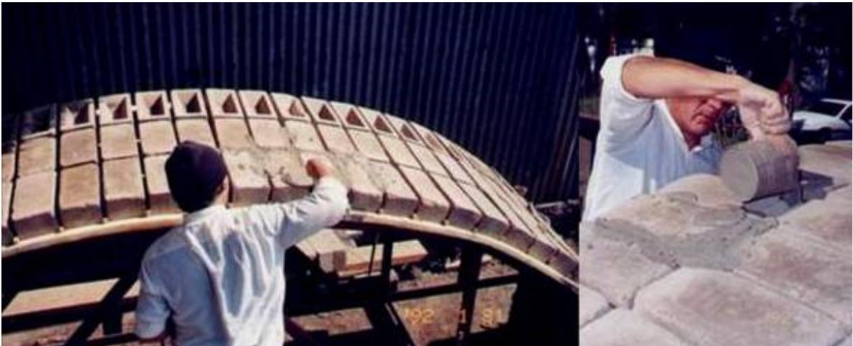
fig. 5 Construcción bóveda
