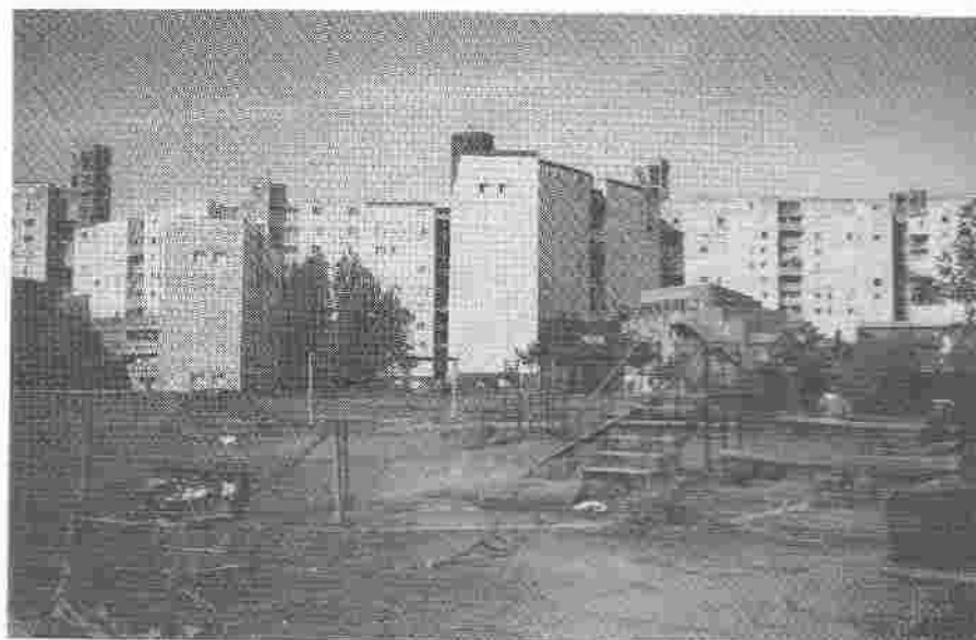
Fig. 15: Conjunto Piedrabuena - Vista de uno de los sectores
