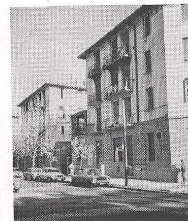
Figura 26. Casa Colectiva Los Andes. Fachada con acceso sobre una de las calles perimetrales.
