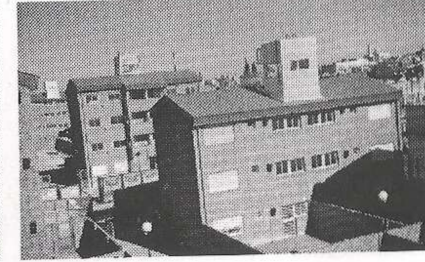
Figura 47. Barrio Lugano (Villa 20). Vista general del conjunto.
